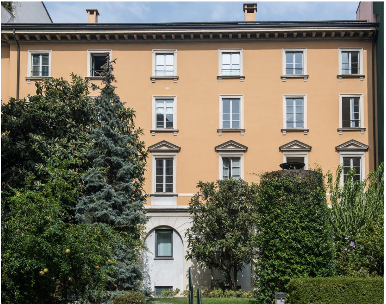
Eurizon Capital SGR, Milano - dettaglio sede
