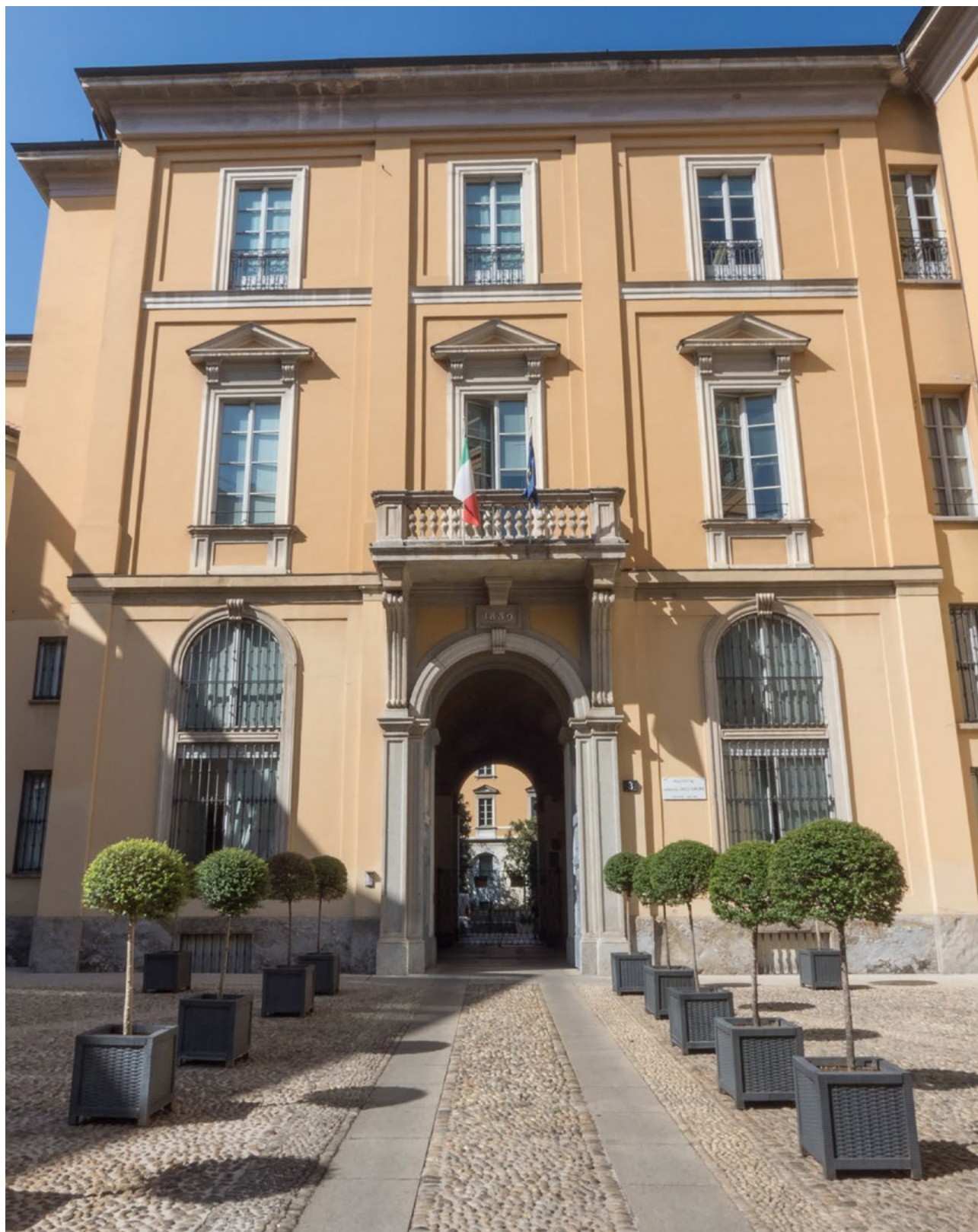
Eurizon Capital SGR, Milano - dettaglio ingresso
